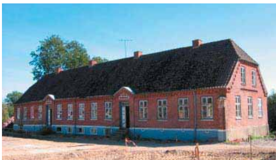
Figur 2.9: Skjøtgårdens stuehus efter renovering. [Realdania, 2006]
